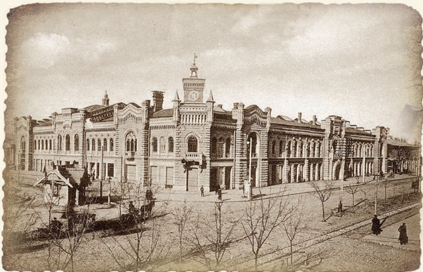
Sediul Primăriei Municipiului Chișinău. începutul sec.XX. Arhitect A. Bernardazzi Headquarters of Chisinau City Hall. Late 20th century. Architect A. Bernardazzi.
